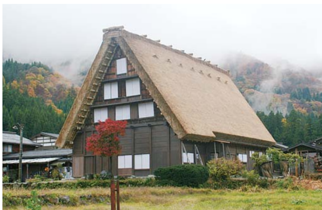
図8：修理後下手側(手前二間が復原部分)
