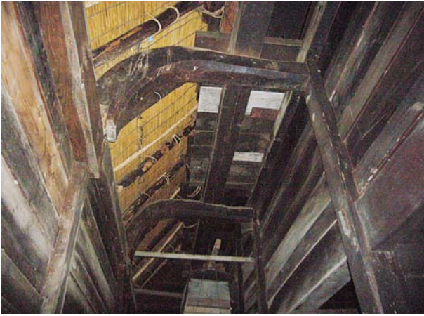
図4：旧西岡家のウシノマヤ・ドジ境部分の曲がり梁
