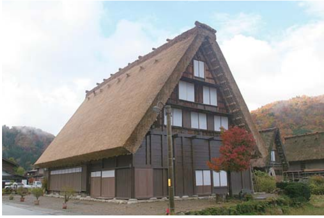
図1：竣工東北側(手前二間分が復原部分)
