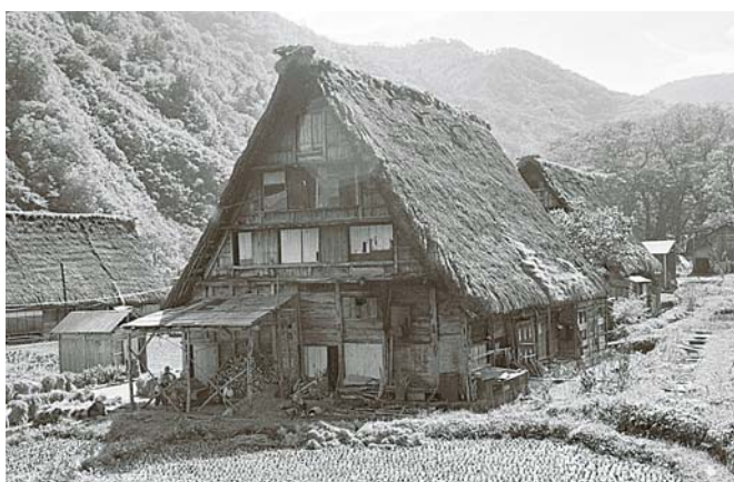
図9：昭和40年代下手側(手前二間が移築時に撤去された。)
