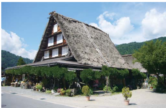
図7：修理前下手側(手前の二間が移築時に建て替えられたトタン落屋)
